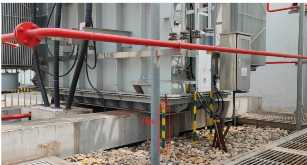
（超声波传感器 油箱安装分布图）
