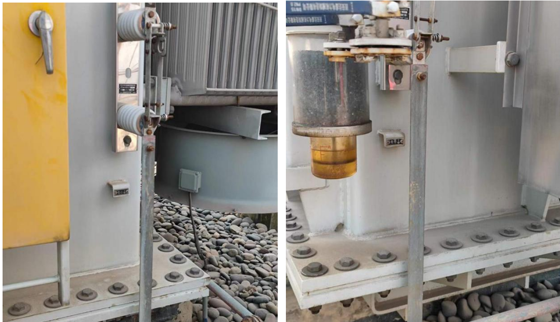
(高频电流传感器 铁芯和夹件接地安装分布图)
